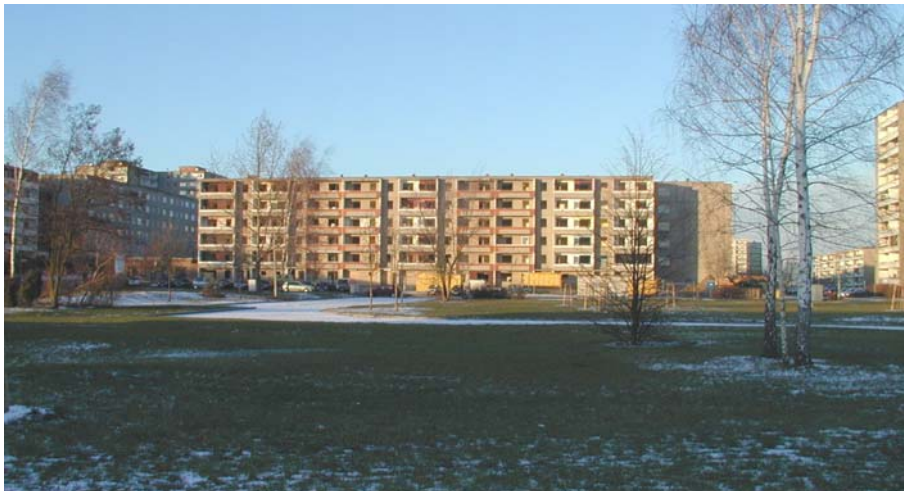
Abb.: Zustand des Wohngebietes zum 01.01.2004
